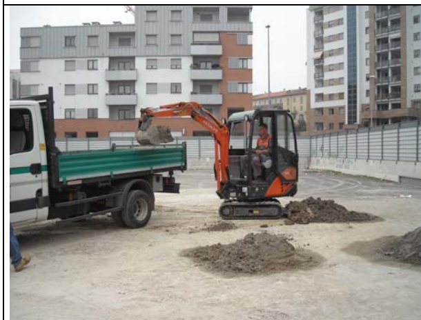
Fase di rimozione e smaltimento del terreno derivante dalle perforazioni
