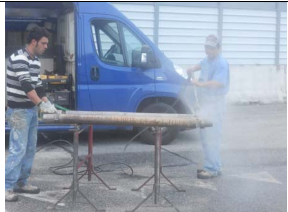
Fase di pulizia dell'attrezzatura
