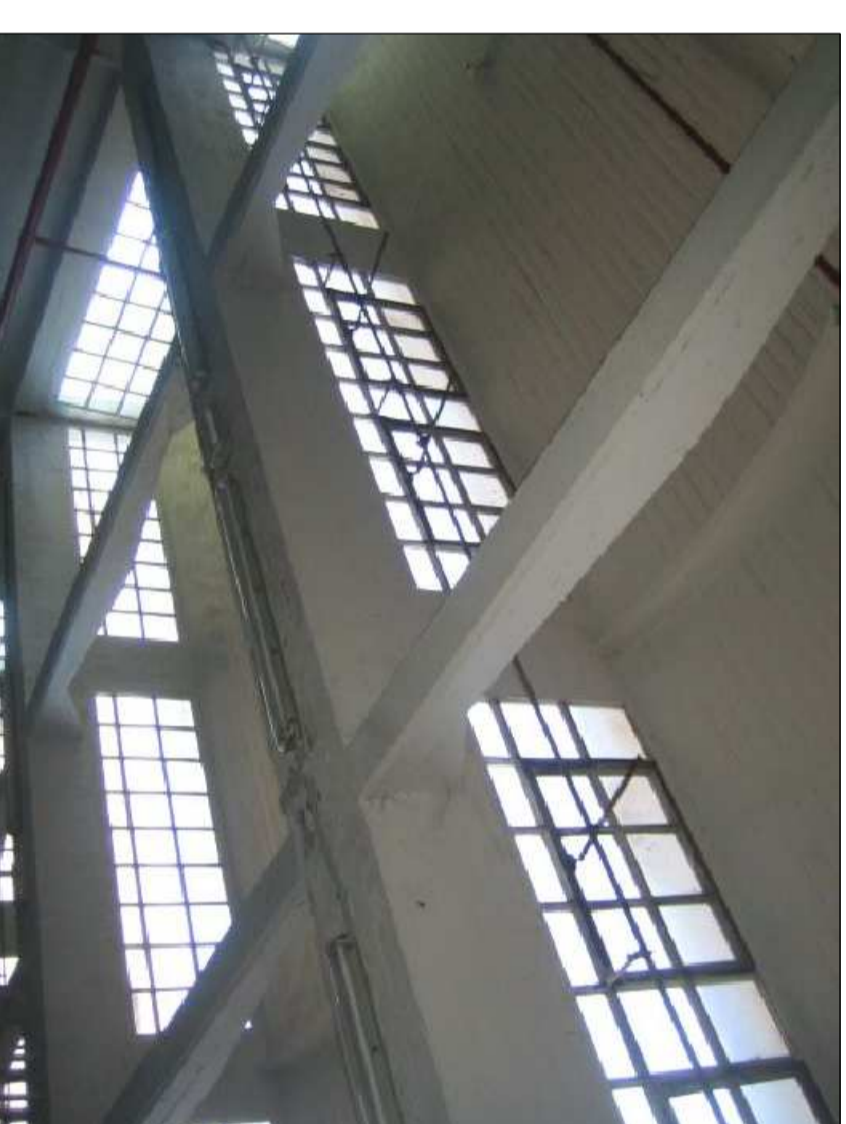
VISTA INTERNA APERTURE ESISTENTI
