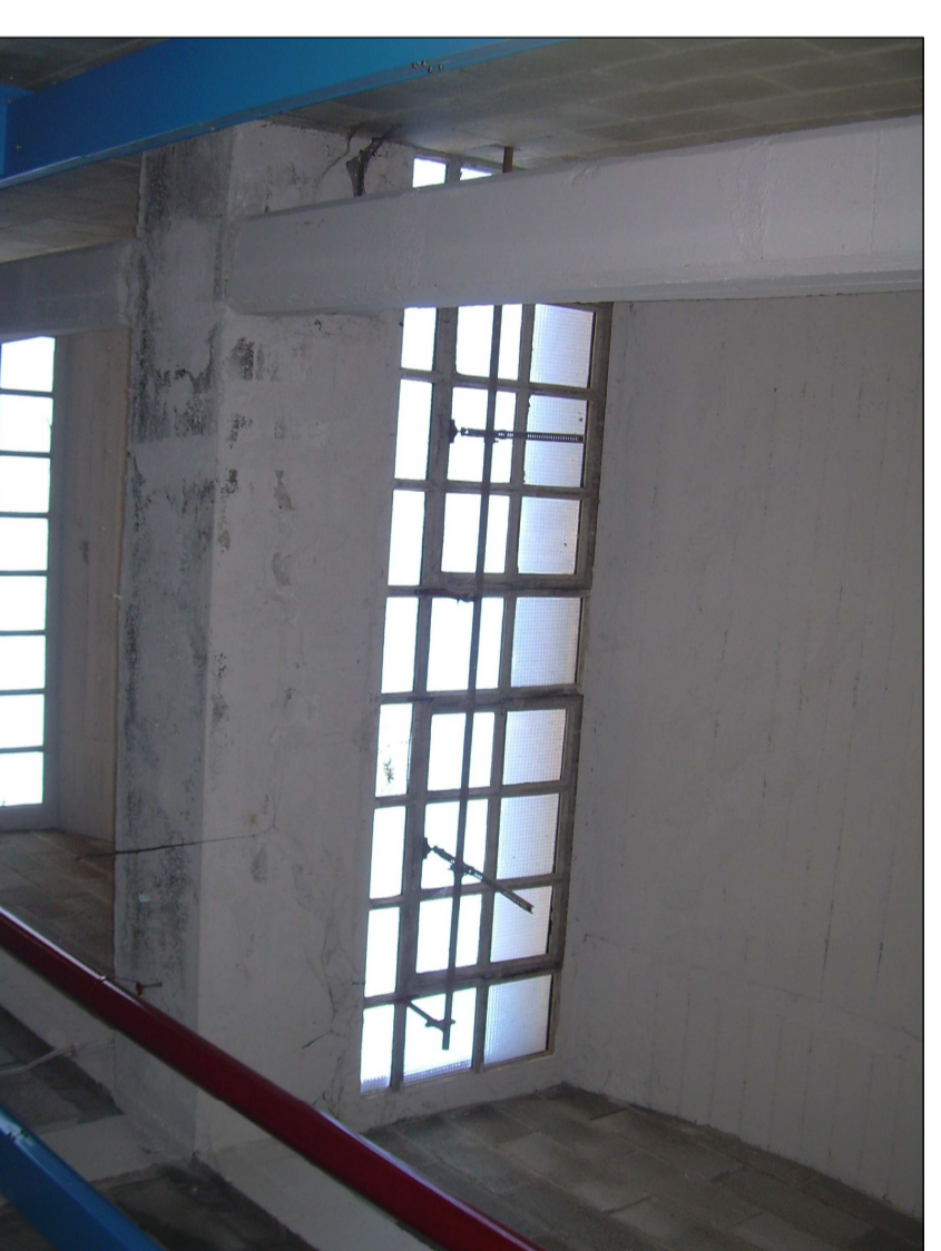
VISTA INTERNA APERTURE ESISTENTI
