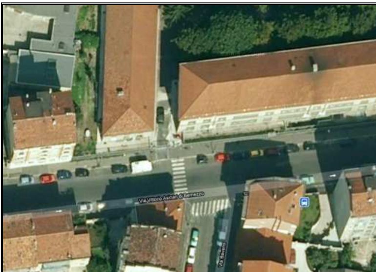
vista aerea ingresso cantiere
