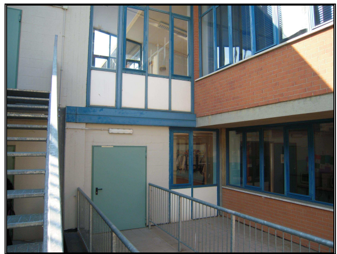
pannelli sottofinestra scala esterna
