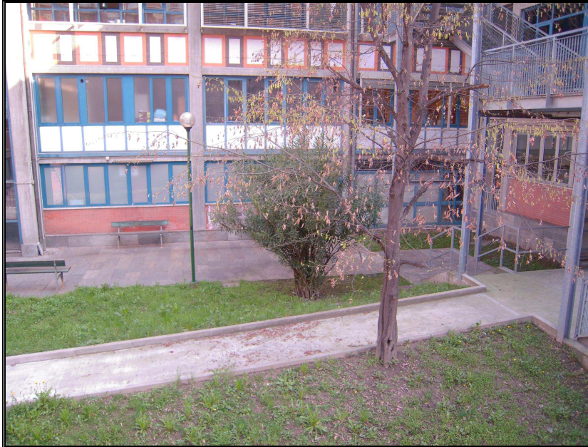
pannelli sottofinestra lato corso Sebastopoli
