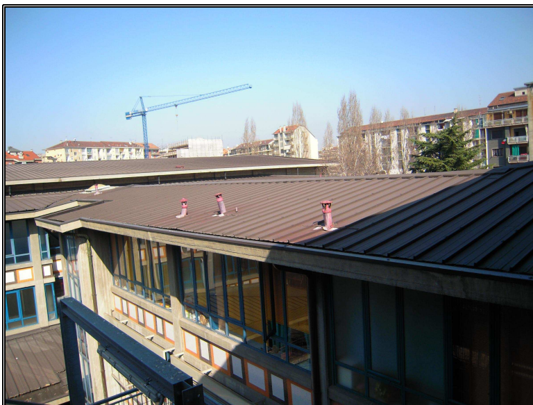
comignoli sulla copertura
