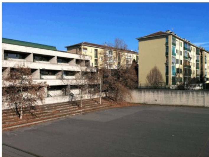
foto 4 - vista della parete est del corpo scolastico centrale e del cortile (scattata da sud)
