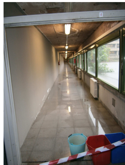
infiltrazioni su corridoio di accesso palestre e servizi igienici
