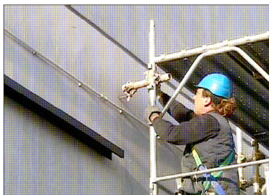
Ancoraggio con barra munita di gancio
