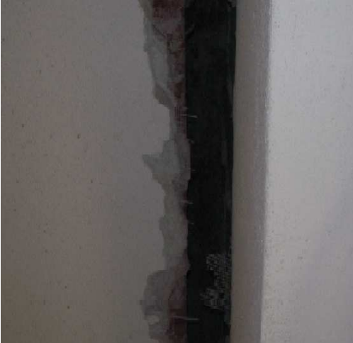
Sezionamento su porzioni murarie angolari. Presenza di armature longitudinali all'interno
