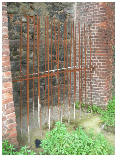
il muro ed i ferri di ripresa
