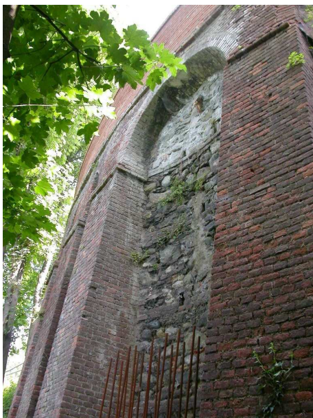
il muro ed i ferri di ripresa
