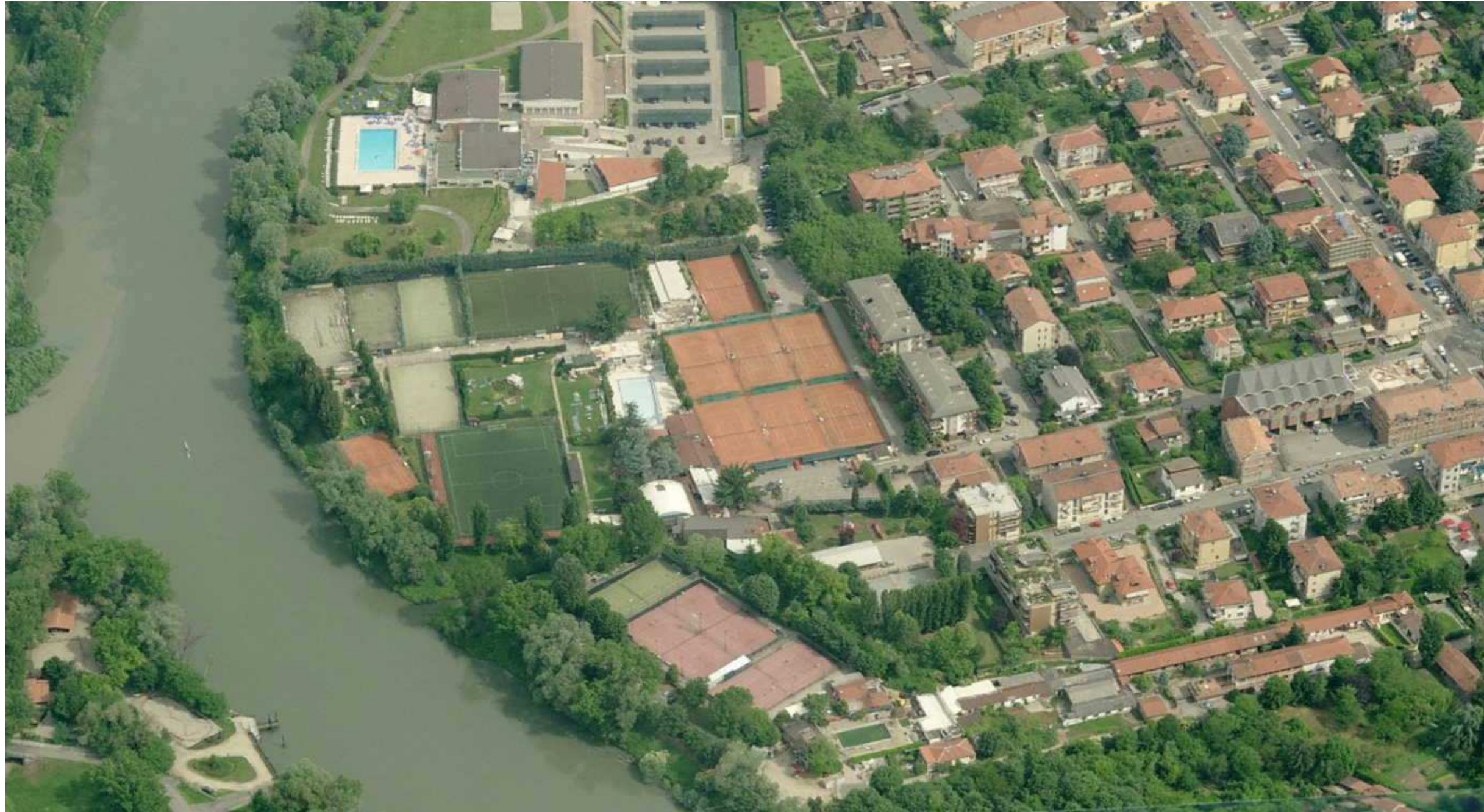
Figura 2 – Vista aerea della sponda destra interessata dall'intervento con l'area del Fioccardo.
