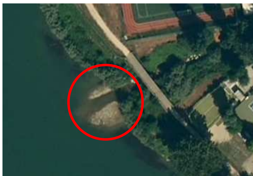
Figura 28 e 29 – Materiale di deposito presente allo sfocio del rio Sappone nel fiume Po
