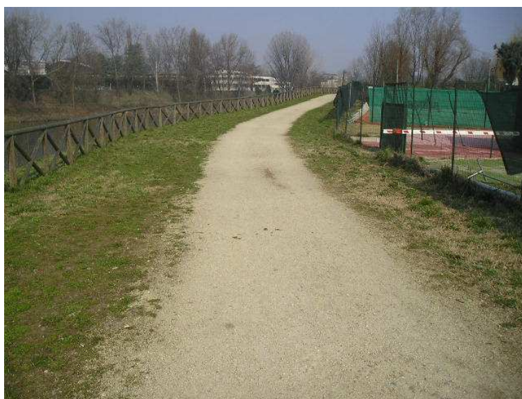
Figura 18 bis – Zona dell’intervento di sopralzo della pista ciclo pedonale
