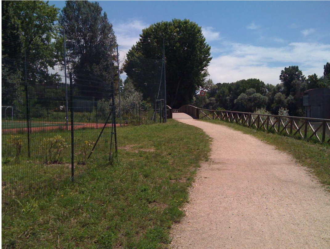
Figura 7 - Pista ciclabile all'altezza del circolo "Master 2006". Sullo sfondo il ponte della pista sul rio Sappone
