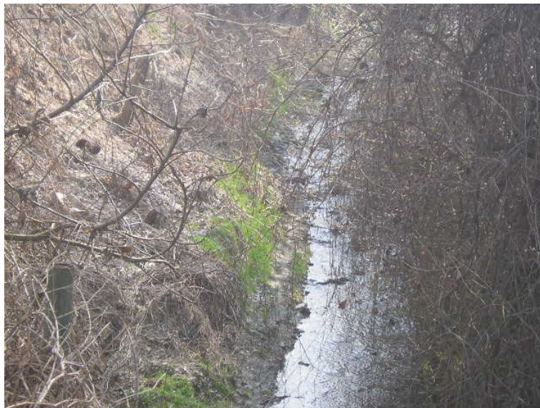
Figura 25 – Intervento di consolidamento del piede della sponda del rio, sulla sinistra nella foto.
