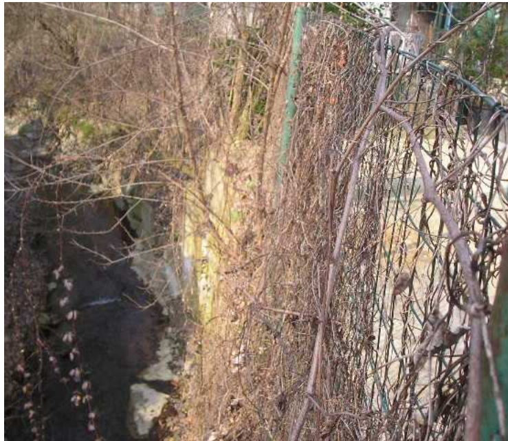
Figura 23 – Muro in c.a. esistente oggetto di intervento
