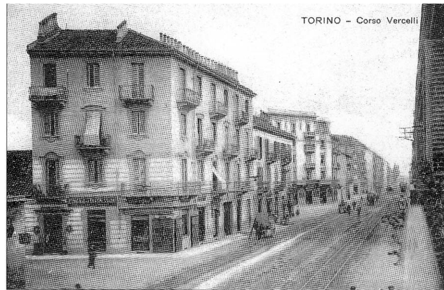
Veduta di corso Vercelli verso la periferia all'altezza di via Belmonte, in Borgata Montebianco. Le case inquadrare sono a tutt'oggi esistenti.
