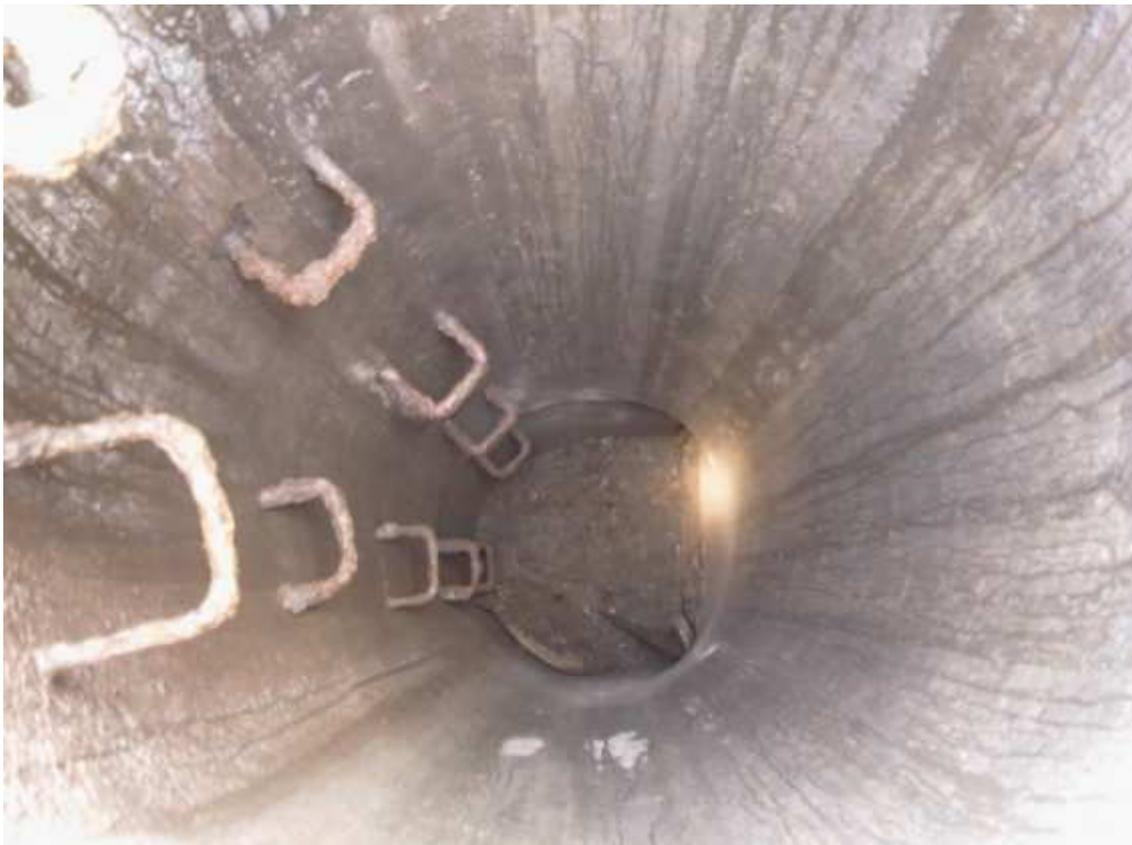
foto 18 - Vista pozzo a “baionetta” fogna nera tubazione ovoidale 70x146
