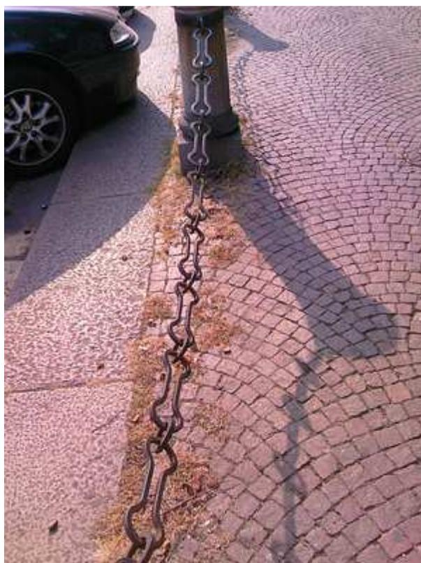
foto 15 – elementi di arredo da recuperare catena in ferro a “osso di pluto”
