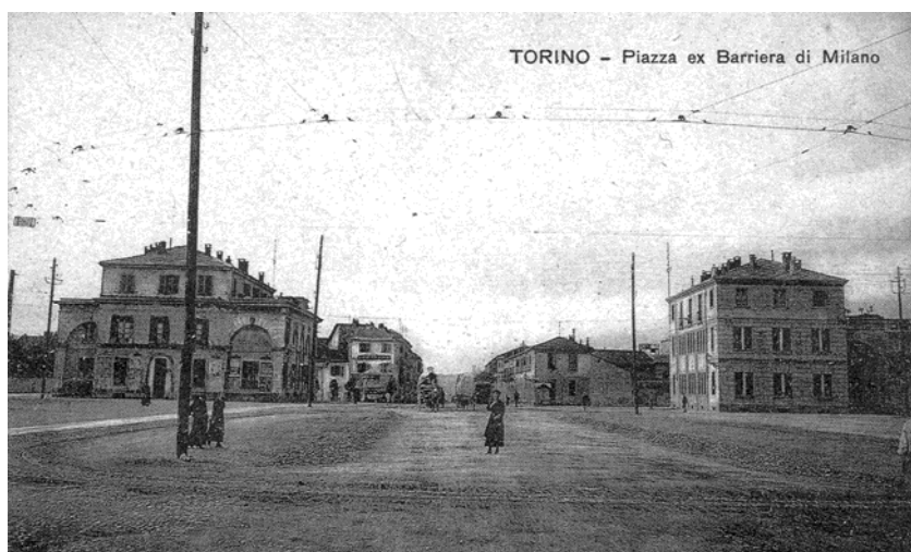
03 - La piazza della Barriera di Milano negli anni '10 del Novecento. I due edifici all'interno della piazza sono quelli preposti alla riscossione dei dazi.
