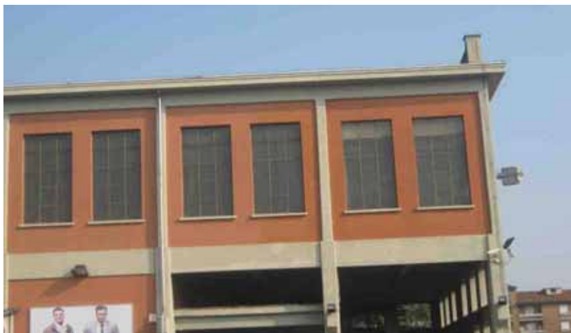
FOTO 1 L'ex stabilimento I.N.C.E.T. di via Cigna
