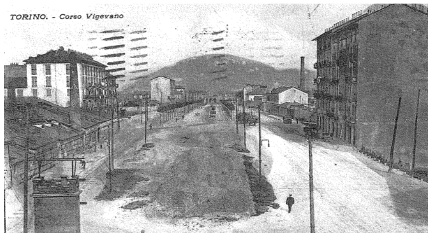
01 - Corso Vigevano ai tempi dell'abbattimento della cinta daziaria del 1853, nei primi anni '10 del Novecento.
