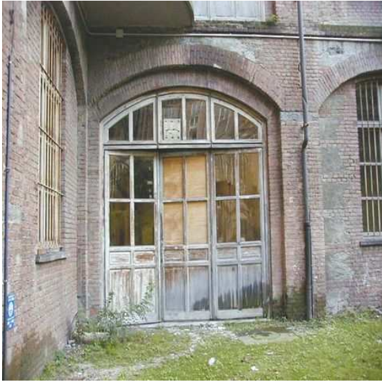
Infissi esterni piano interrato
