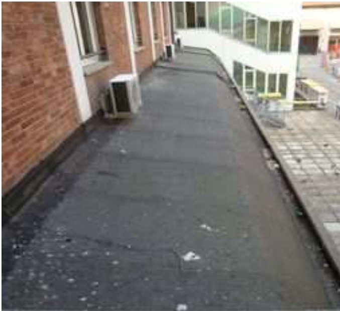
Manti di copertura_ rifacimento impermeabilizzazioni
