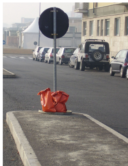
ZAVORRAMENTO PER SEGNALETICA VERTICALE
