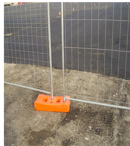
BASAMENTO IN CLS PLASTIFICATO DI SUPPORTO ALLA RECINZIONE
