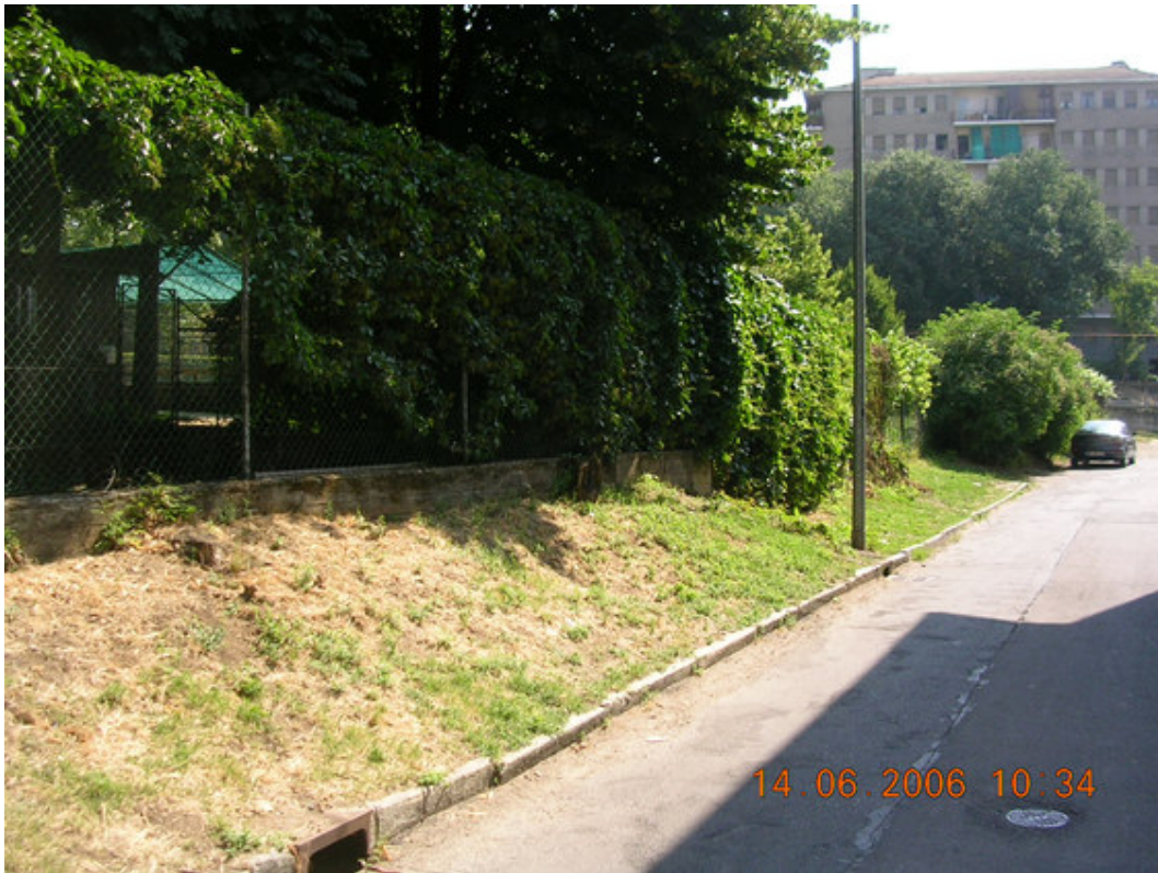
FOTO 5: Vista scarpa campi bocce
