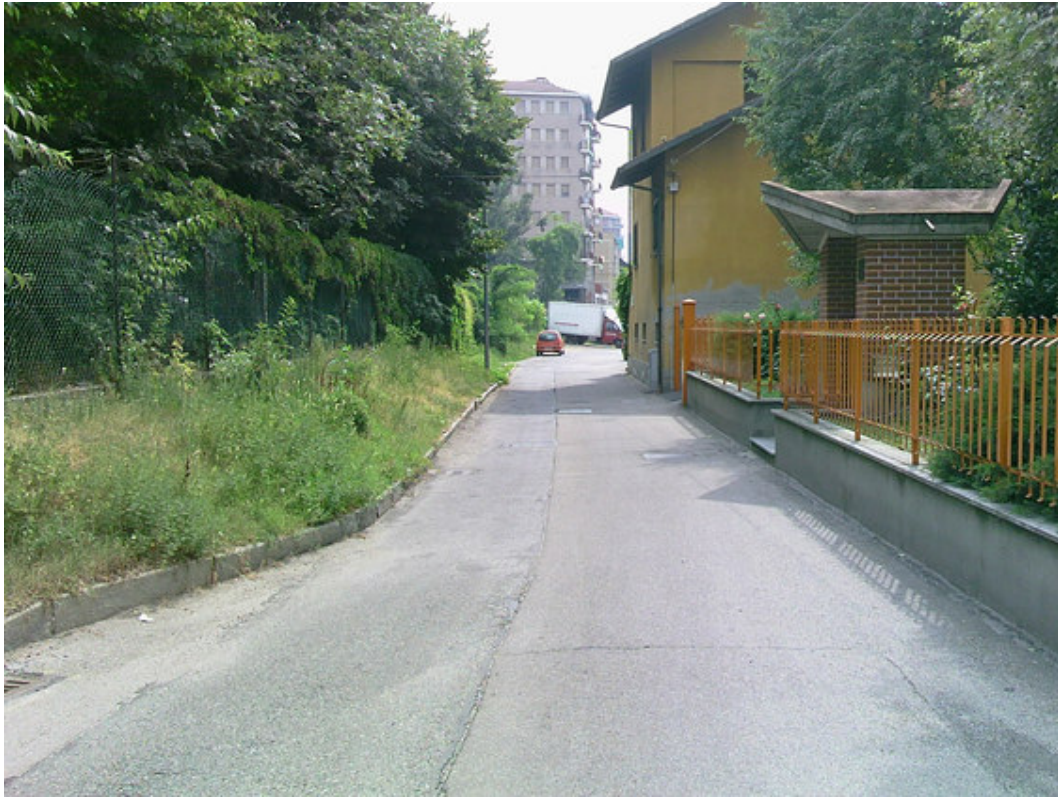
FOTO 9: Via Torrazza Vista restringimento.
