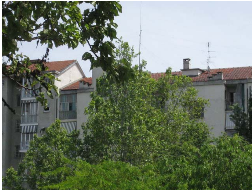
Vista della copertura dal cortile
