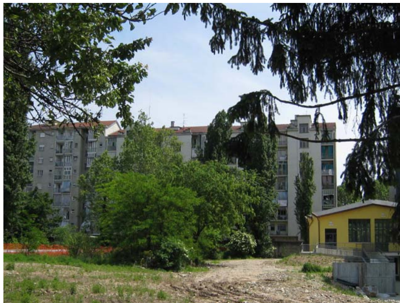
Vista dal cortile
