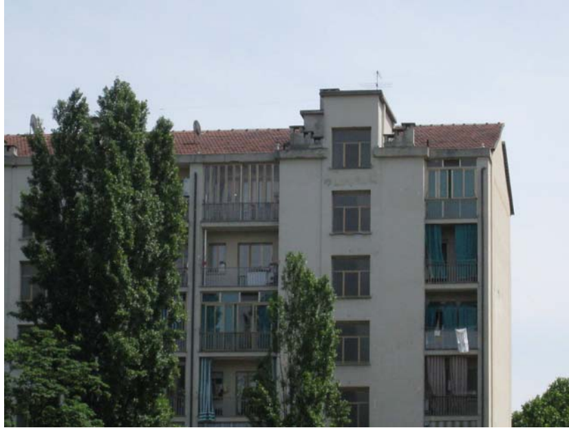
Vista della copertura dal cortile
