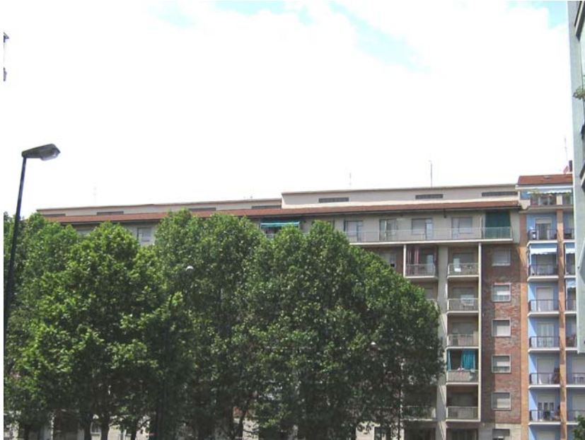
Vista da c.so Lombardia la copertura
