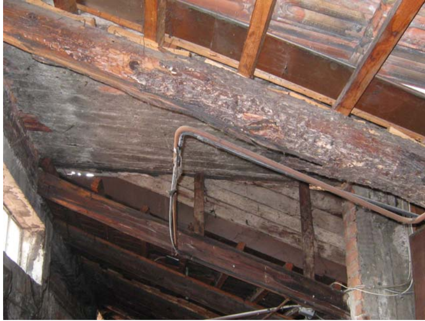
Vista travi del sottotetto da rimuovere
