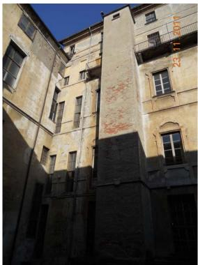
Verificata l'impossibilità tecnica di realizzare un nuovo impianto ascensore con castelletto esterno all'interno del cortile (interessato dall'area archeologica e da corridoi interrati di collegamento), il progetto prevede il rifacimento dell'impianto ascensore all'interno del vano corsa esistente nel cortile.
