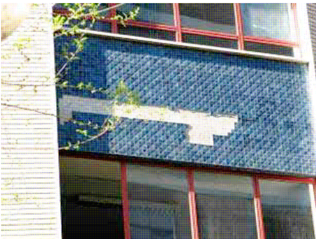
Particolare del distacco del rivestimento esterno e di un serramento in cui è presente la condensa all'interno del vetrocamera
