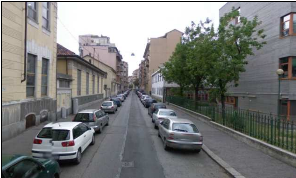
VISTA DI VIA BALME
