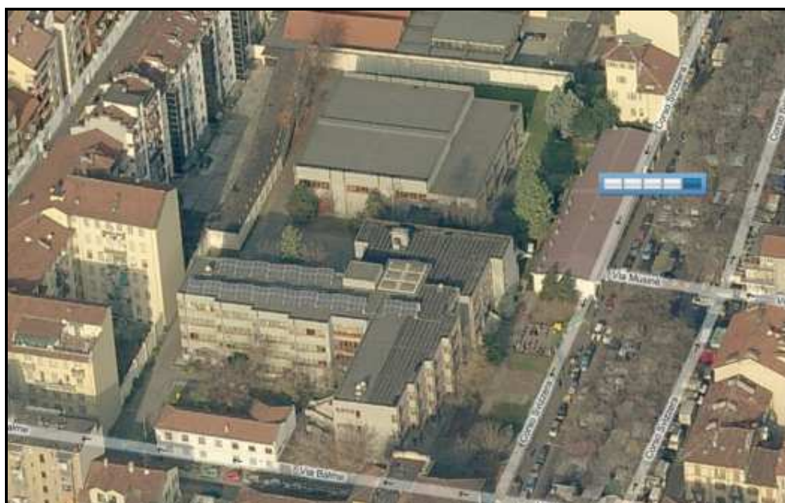
VISTA DI VIA BALME
