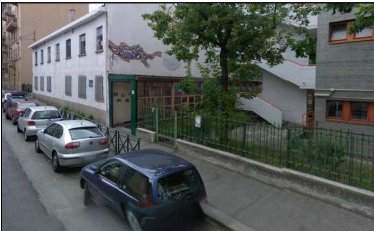
INGRESSO SCUOLA DELL'INFANZIA VIA BALME 42
