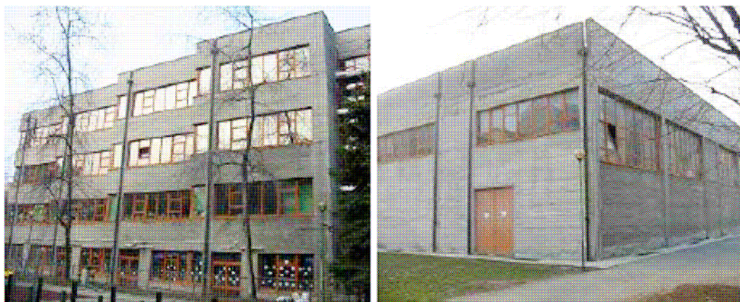
Facciata del corpo centrale e palestra
