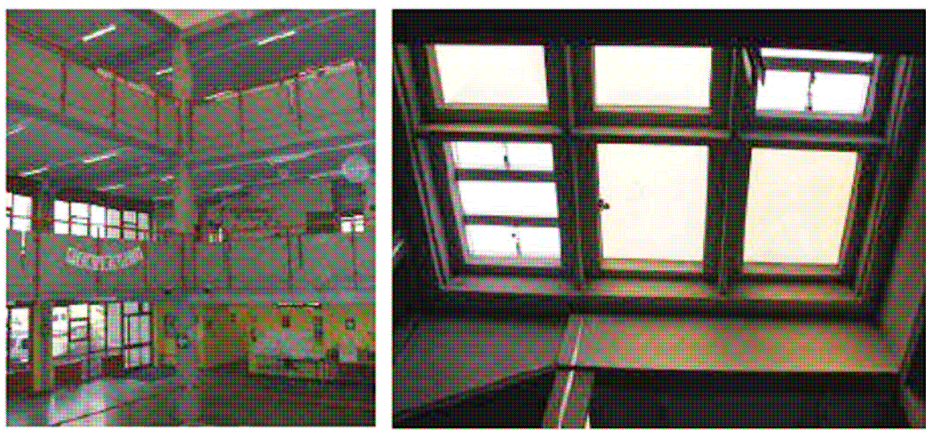
Atrio centrale e lucernari in copertura
