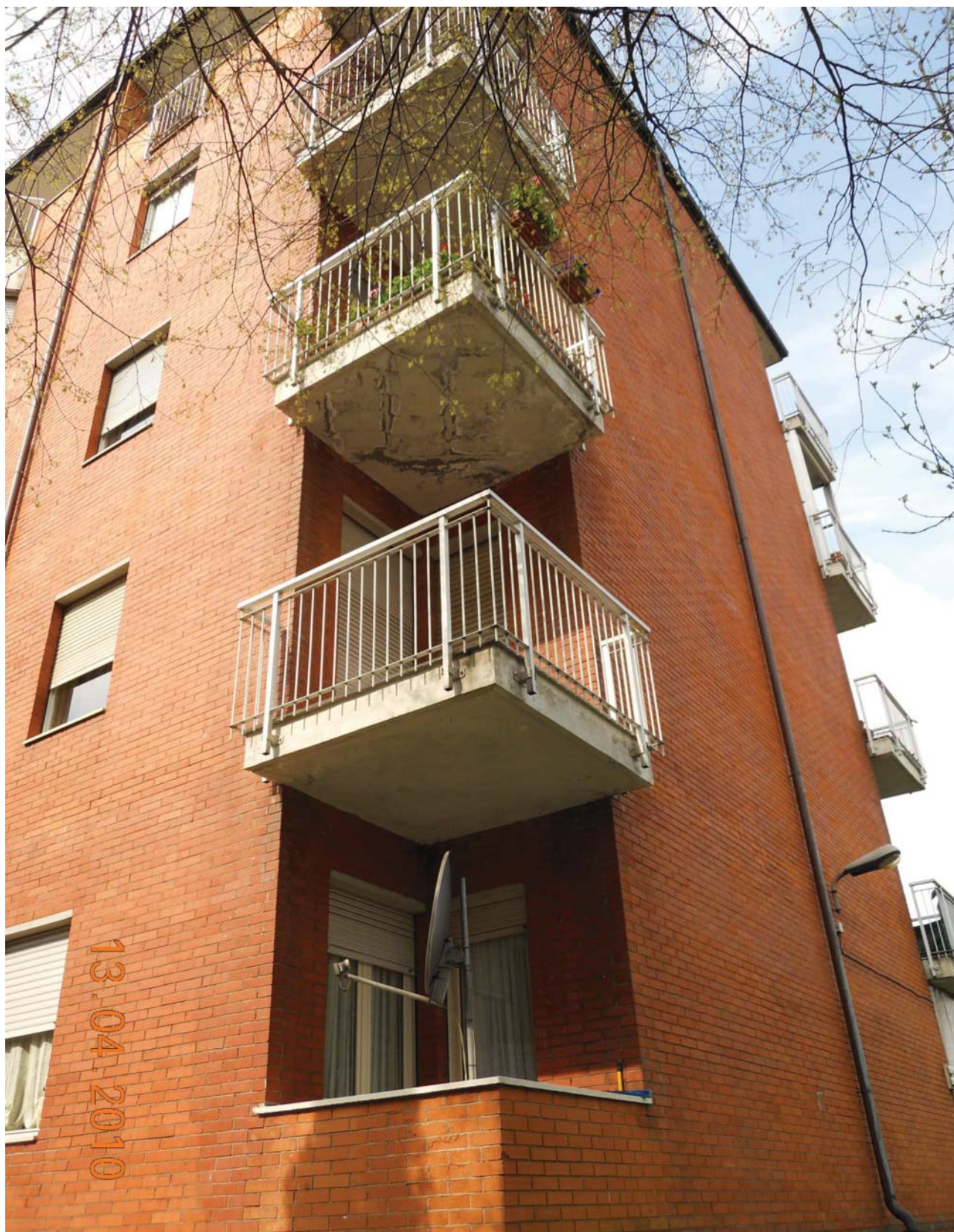
PERTICOLARE BALCONI LATO VIA REISS ROMOLI
