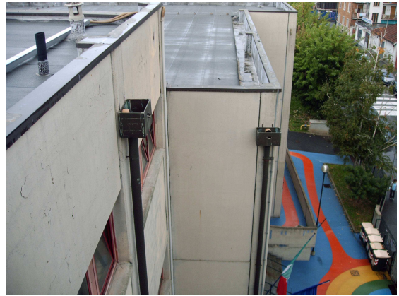
Particolare dei lucernari e sistema di smaltimento acque meteoriche
