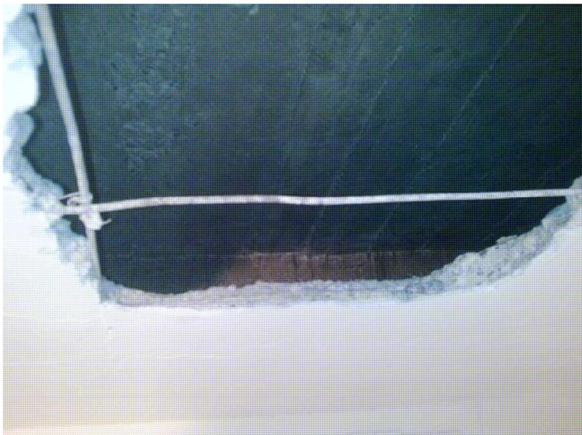
3. Demolizione e rimozione di controsoffitti pesanti in canniccato nella scala dell'alloggio custode e realizzazione di nuova controsoffittatura leggera in pannelli di fibra minerale.
