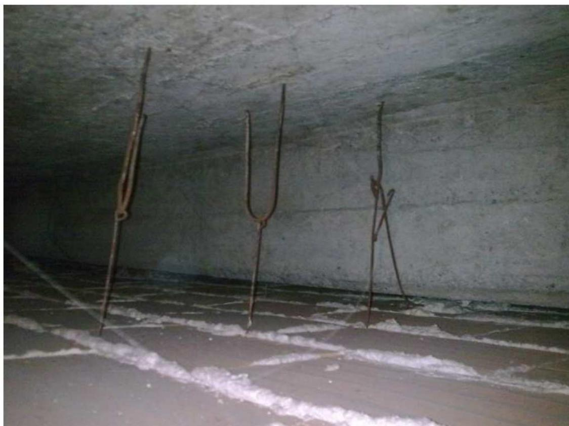
2. Verifica tecnica strutturale di controsoffitti pesanti in cls armato ed ispezione dello spazio racchiuso tra l'intradosso del solaio in c.a. e la controsoffittatura in questione presenti nella manica principale lato corso Svizzera sui tre piani fuori terra.
