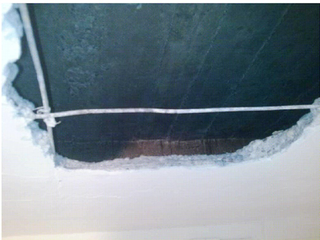
Demolizione e rimozione di controsoffitti pesanti in canniccato nella scala dell'alloggio custode e realizzazione di nuova controsoffittatura leggera in pannelli di fibra minerale.
