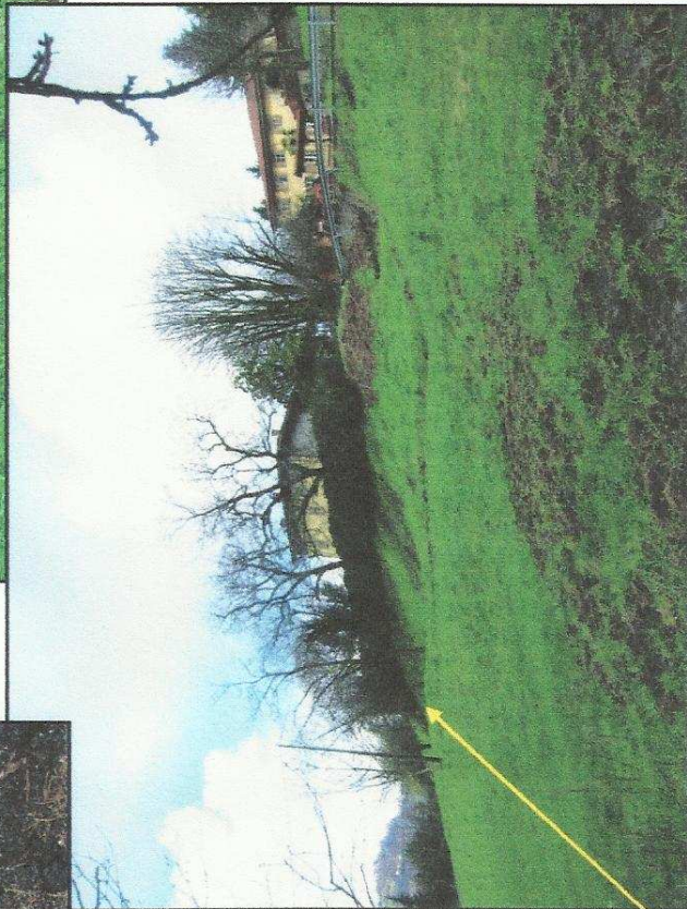
Foto 5: panoramica del corpo di accumulo; si noti il rigonfiamento della superficie topografica al piede.
