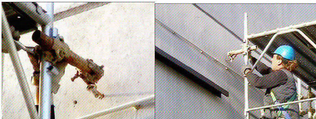
Ancoraggio con barra munita di gancio
