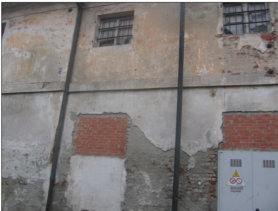
Esterni, lato Via Sambuy
