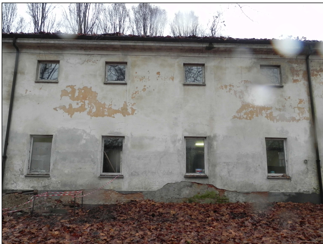
La manica verso il parco, lato parco
