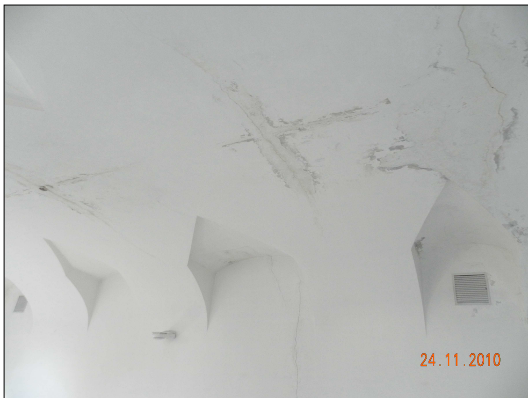
Interni_lato manica parco_particolare volta
