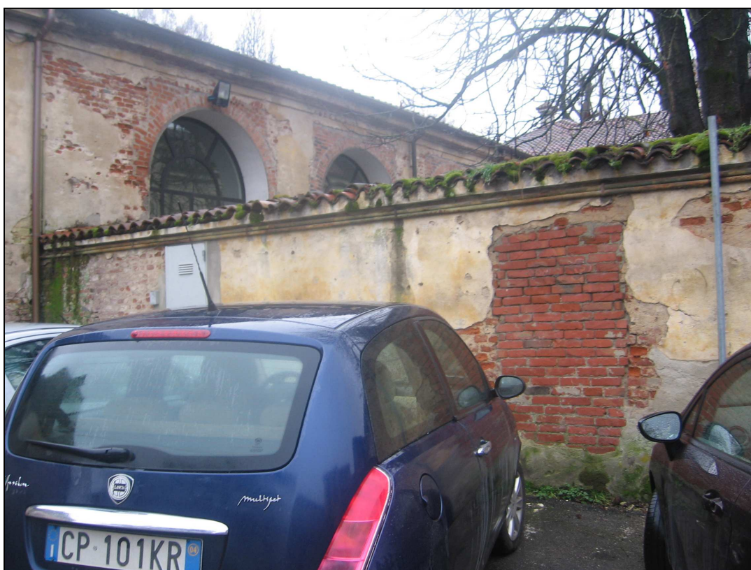
Esterni, lato Piazzetta Cavour_ Particolare ingresso tamponato
