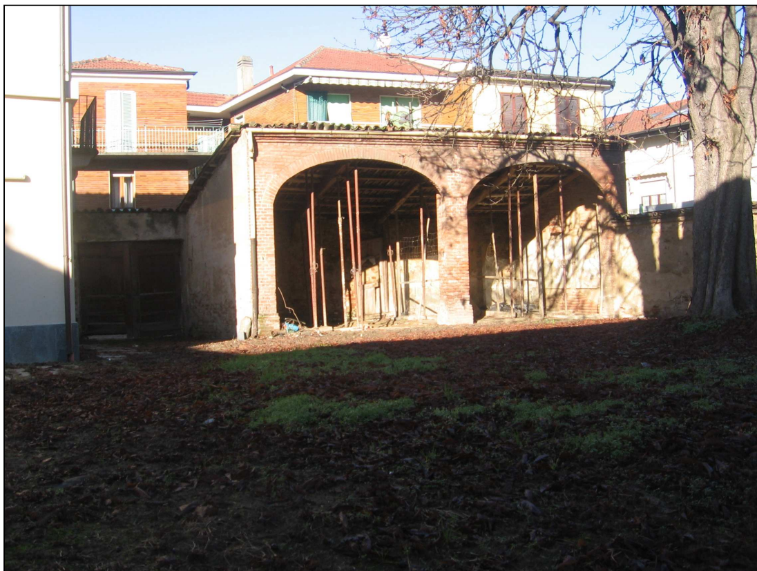
Esterni, lato cortile_ Particolare tettoia
