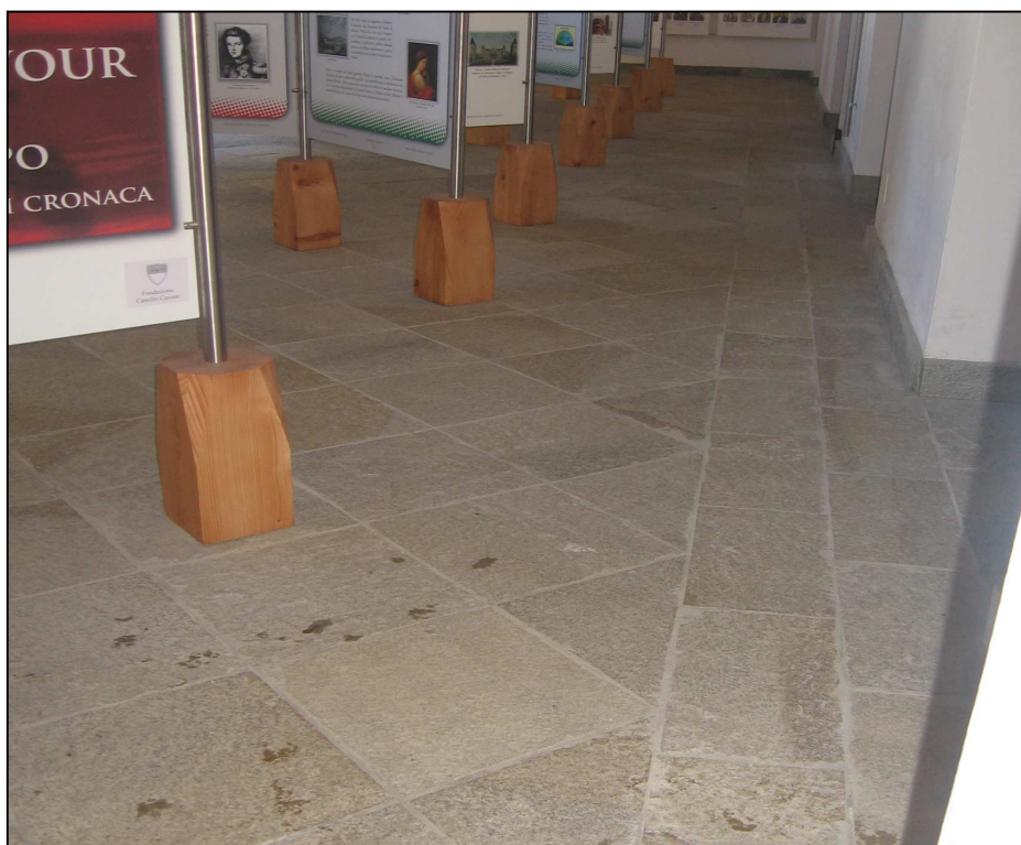
Sala esposizione_particolare pavimentazione
