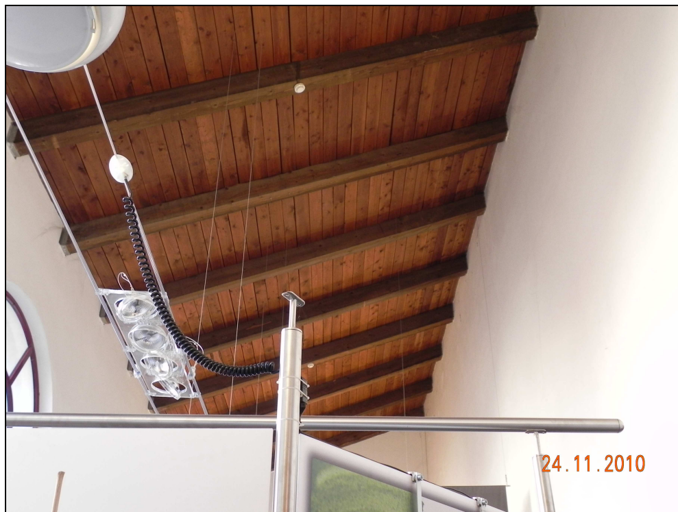
Sala esposizione_particolare copertura
