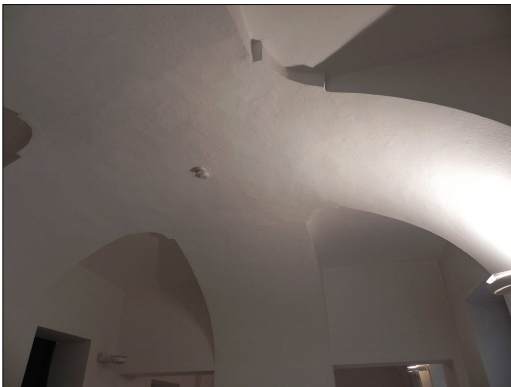
Sala espositiva/conferenze, lato cortile_ Particolare volta
