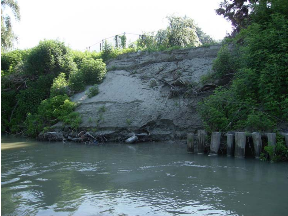
FINE INTERVENTO TIPO C (confine centro sportivo SISPORT FIAT)
