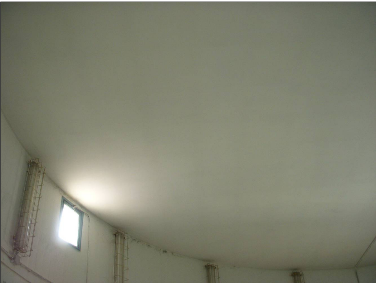
Figura 10 - Particolare della copertura del locale polivalente
