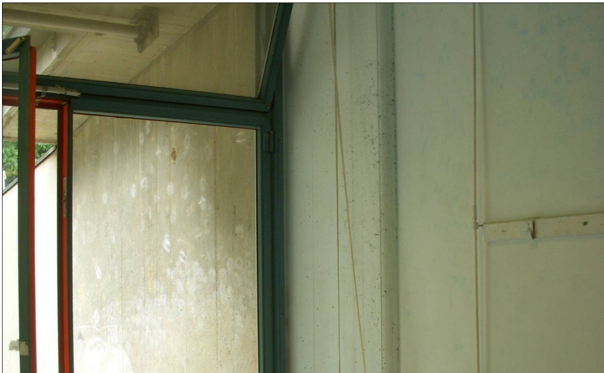
Figura 8 - Dettaglio della giunzione tra soffitto in c.a. e parete interna in laterizio
