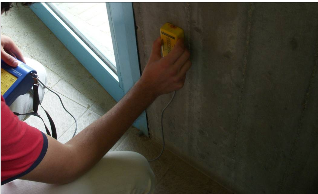
Figura 16 - Esecuzione di un rilievo con pacometro
