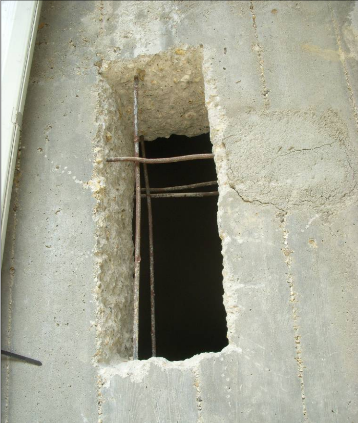
Figura 9 - Vano per aerazione ricavato nel setto in c.a. con vista armatura
