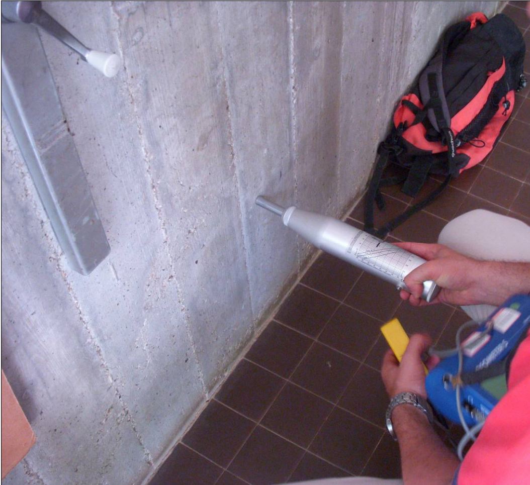
Figura 15 - Esecuzione di una prova sclerometrica
