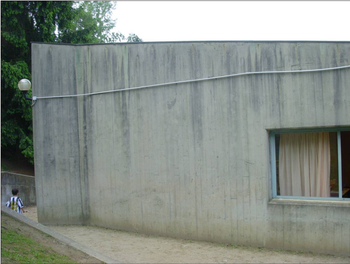
Figura 3 - Vista di uno dei setti in c.a.
