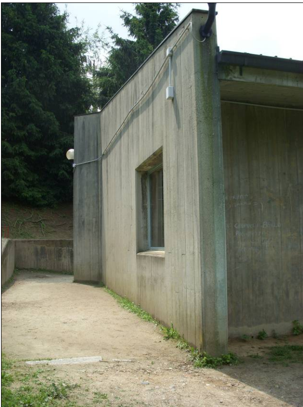
Figura 6 - Vista di dettaglio dei setti strutturali
